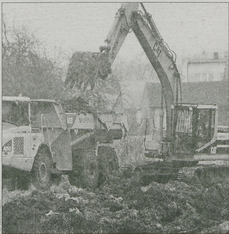
Prace potrwać aż do wiosny
