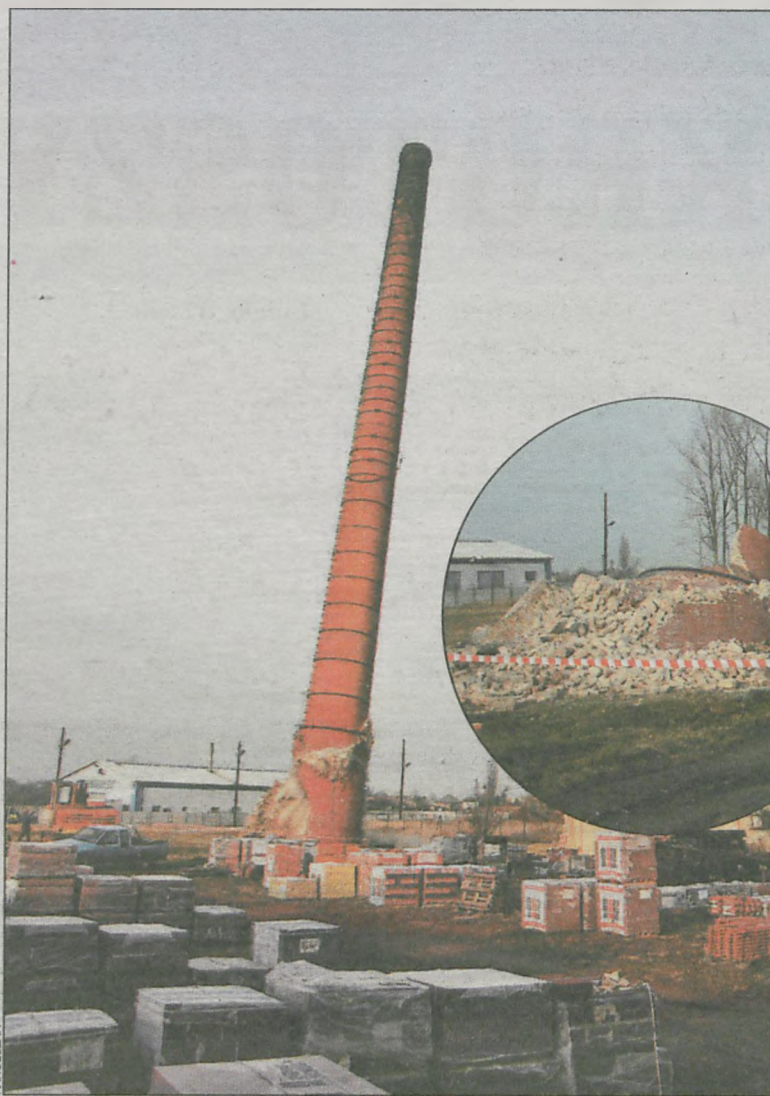
Komin miał 49 m wysokości, średnica u podstawy 4,25m, a u wylotu 1,4 m
