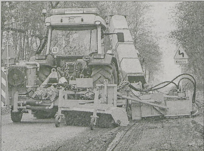
Ścinarka to urządzenie niezbędne w pracy drogowców
