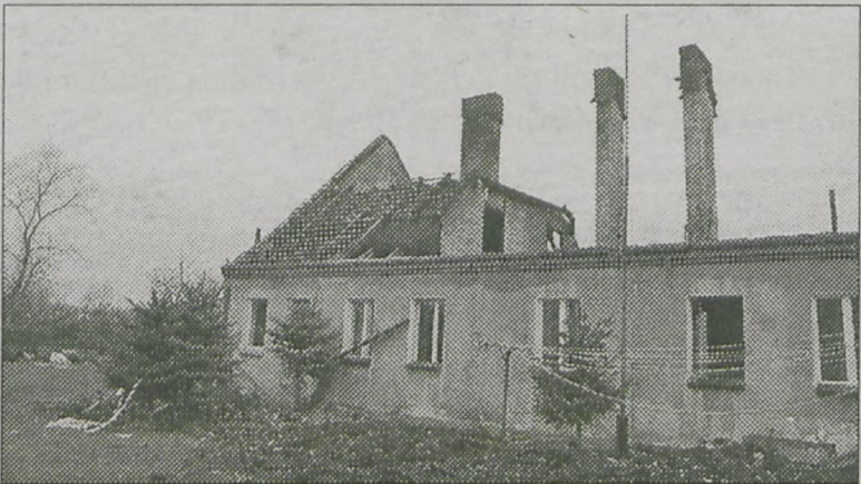
Pożar spowodował wielkie zniszczenia
