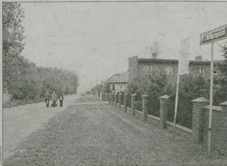
Mieszkańcy tej ulicy z ulgą przyjęli wiadomość o jej remoncie
