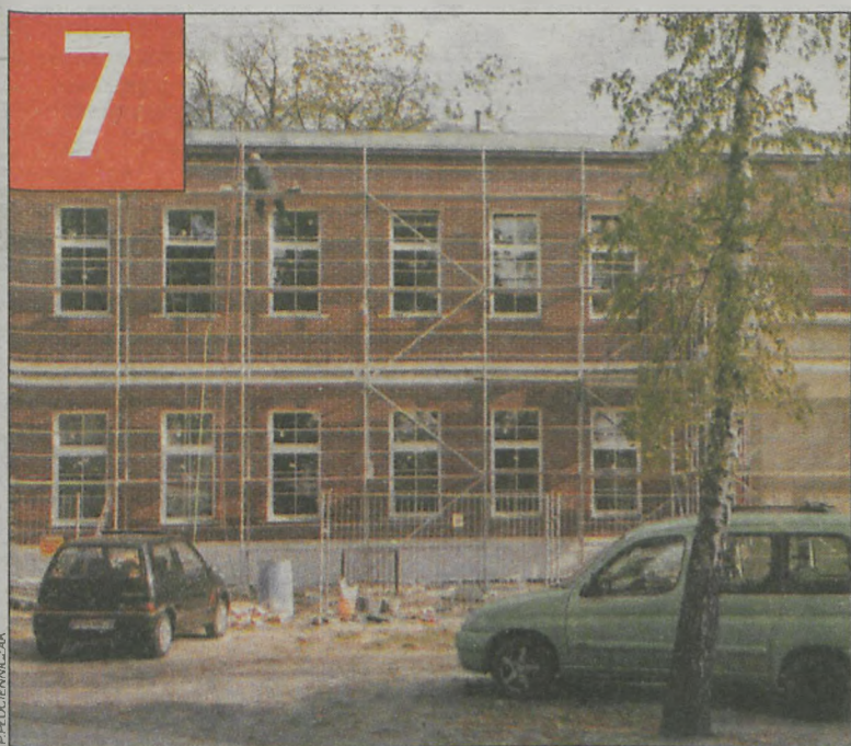
Szpital na ul. Mickiewicza jest w rozbudowie, a w Koźminie znika jeden oddział
