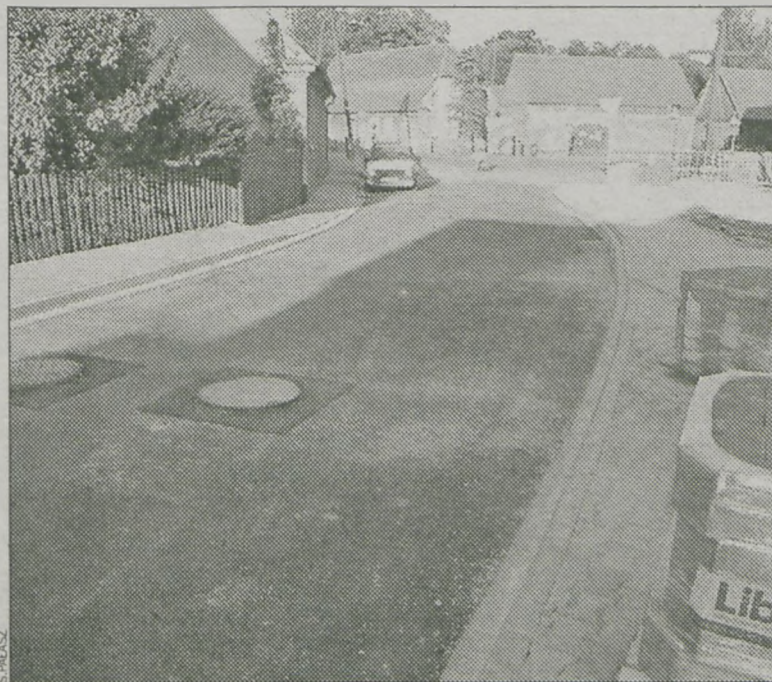
Na ul. 24 stycznia położona zostanie jeszcze jedna warstwa asfaltu
