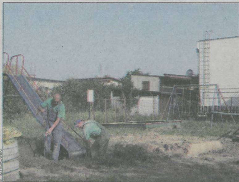
Plac będzie przesunięty i ogrodzony. Prace wykonuje „Mał-Pol” z Krotoszyna
