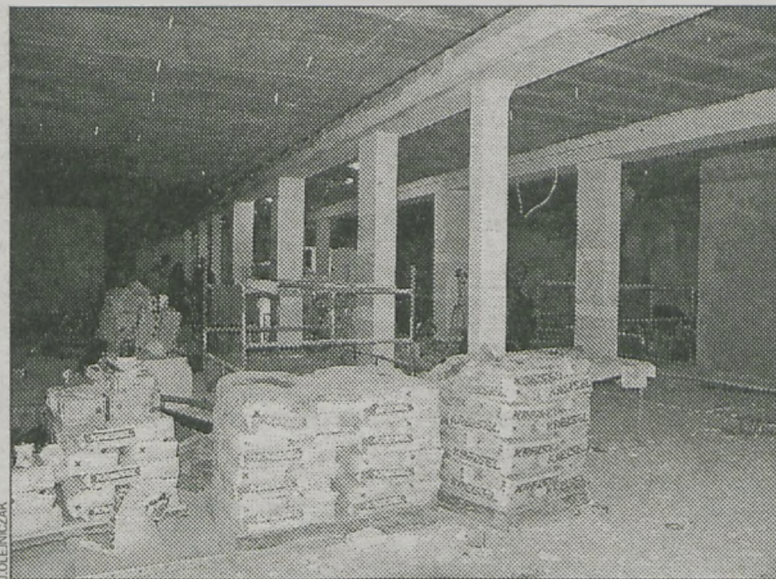
Niedługo zniknie problem ze swobodnym przejazdem wózków sklepowych
