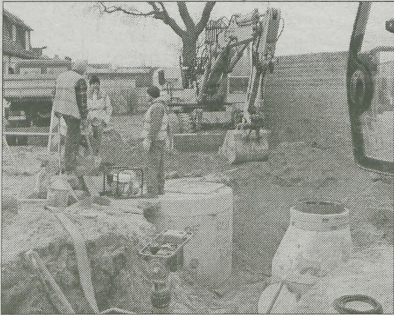
Roboty budowlane przy kanalizacji pochłonię 11 mln zł
