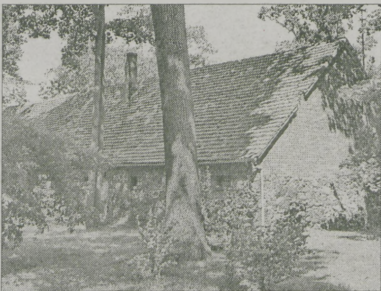
W tym obiekcie wymienione zostaną dach oraz drzwi i okna
