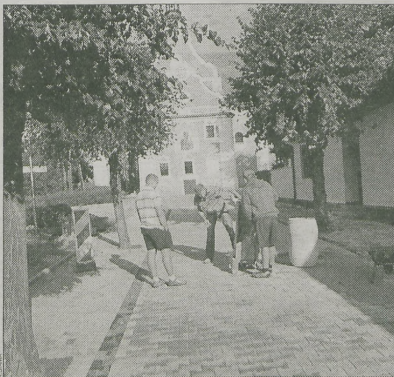
Budowa drogi łączącej rynek z kościołem św. Michała Archaniola dobiega końca
