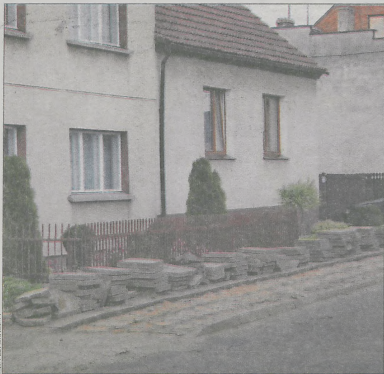
Obecnie trwa rozbiórka chodnika
