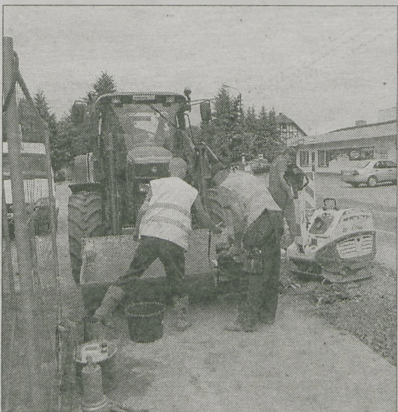
Prace przy budowie kanalizacji na ulicy Armii Poznań
