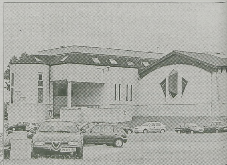
Budowę kortów tenisowych planowano w poprzedniej dekadzie
