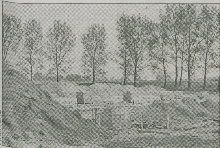
Na razie zostały zalane fundamenty
