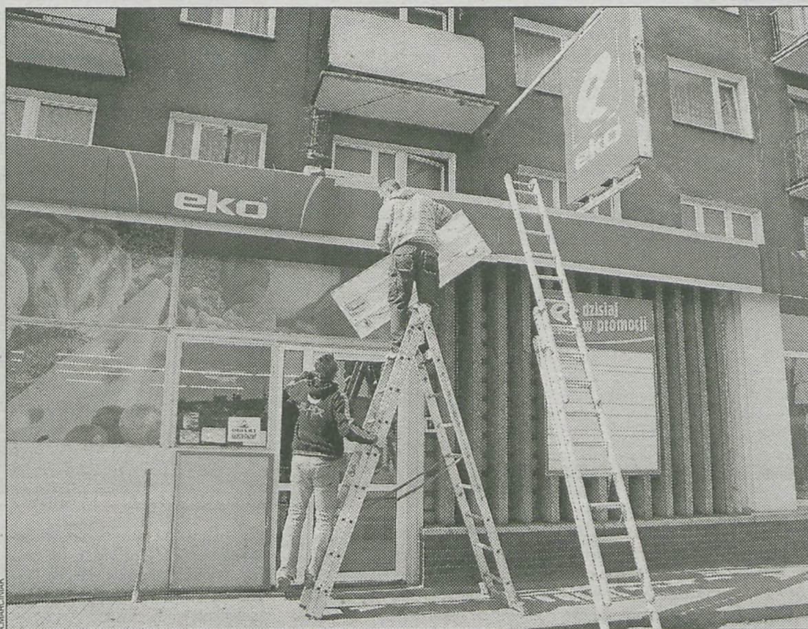
29 marca zdemontowano sztyt sklepu na ul. Sienkiewicza
