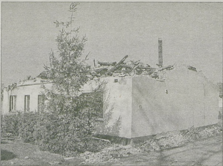
Spalony szkielet budynku nadal stoi
