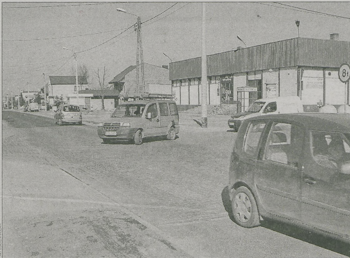
Kontrowersyjny próg zwalniający na skrzyżowaniu ul. Grudzielskiego i Spokojnej
