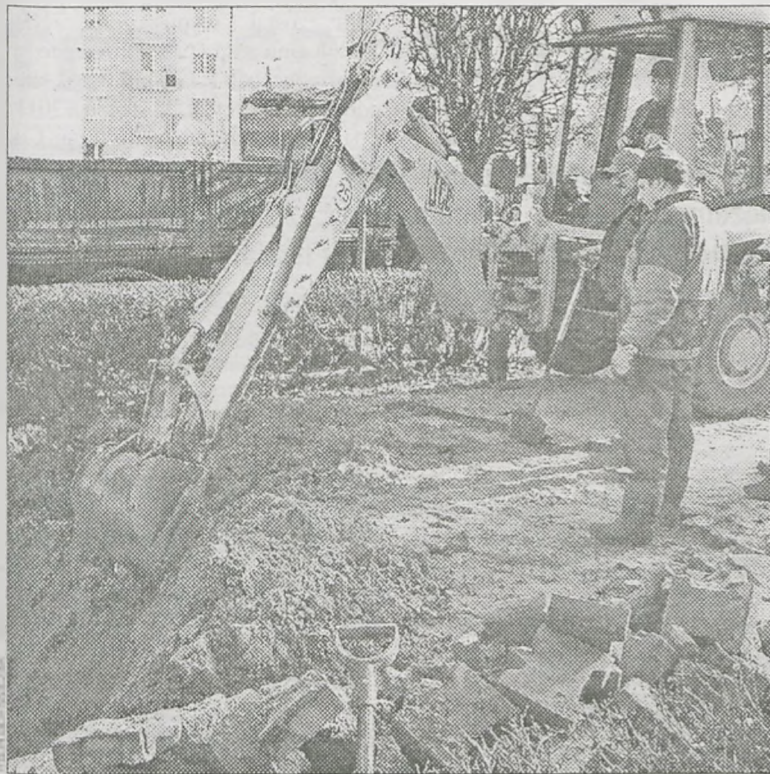
By dostać się do rur, trzeba było rozkopać chodnik
