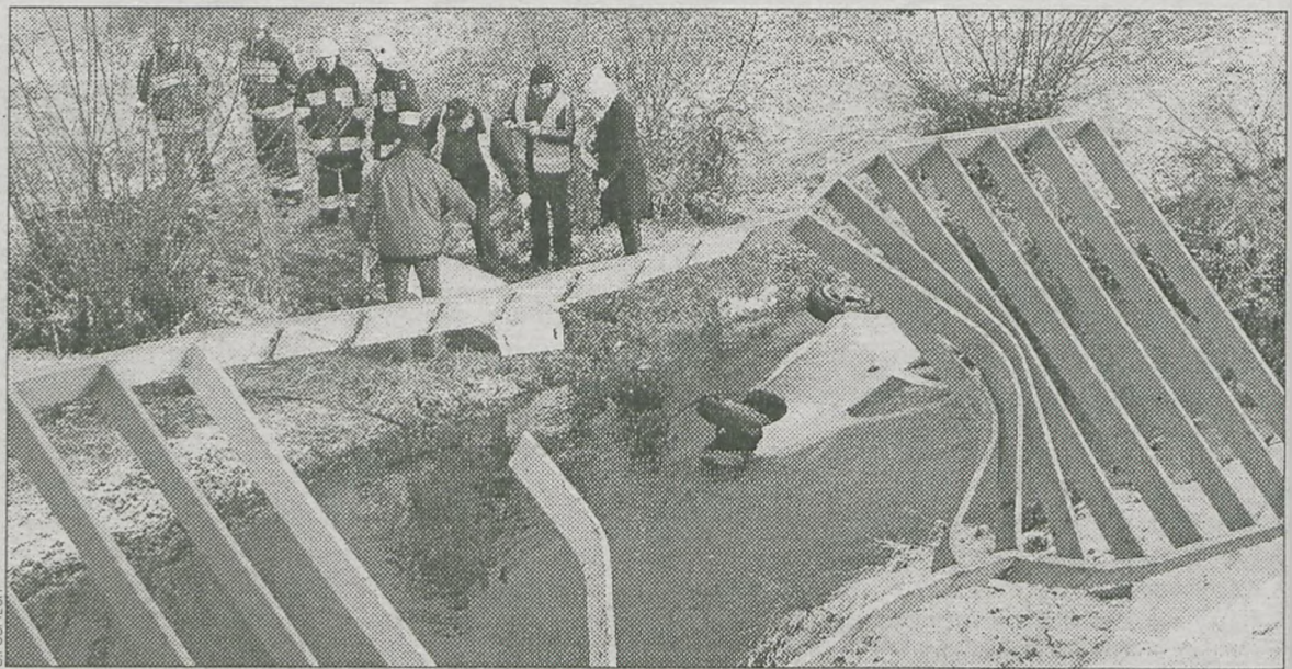
Most wybudowano w 1958 r., ale od kilkunastu lat nie był gruntownie remontowany
