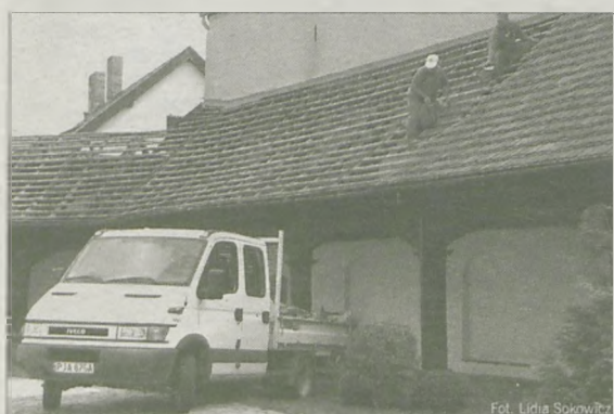
KRUŻGANKI wokół kościoła św. Marcina w Jarocinie przechodzą gruntowny remont
