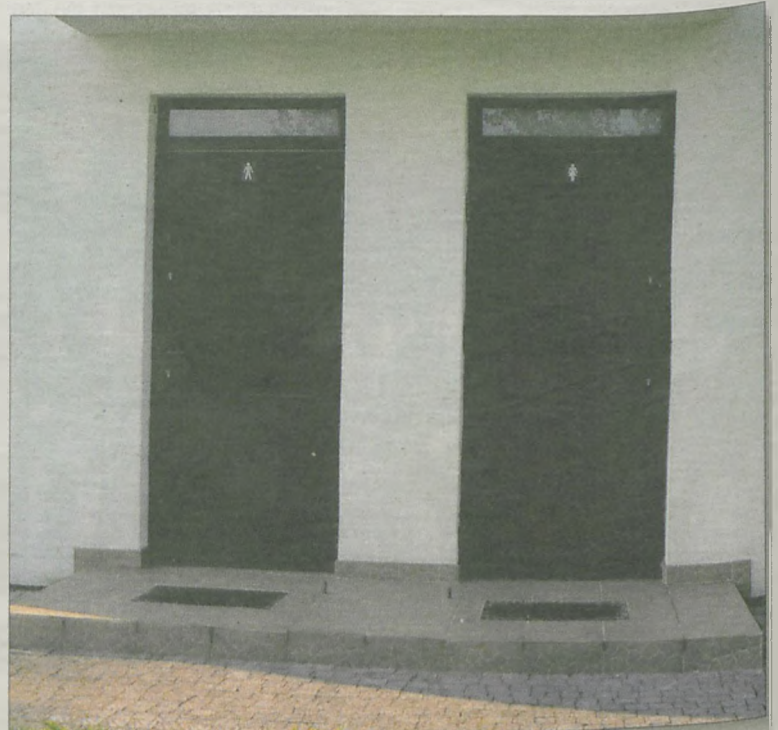
TOALETY NA JAROCIŃSKIM CMENARZU KOMUNALNYM mieszczą się w budynku domu przedpogrzebowego
