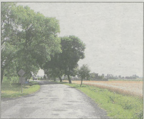
NAWIERZCHNIA DROGI prowadzącej z Woli Książęcej do Wysogotówka już wkrótce będzie lepsza
