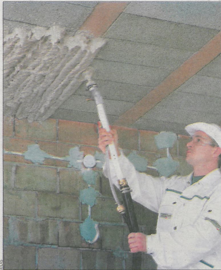
Nakładanie tynku należy rozpocząć od sufitu
