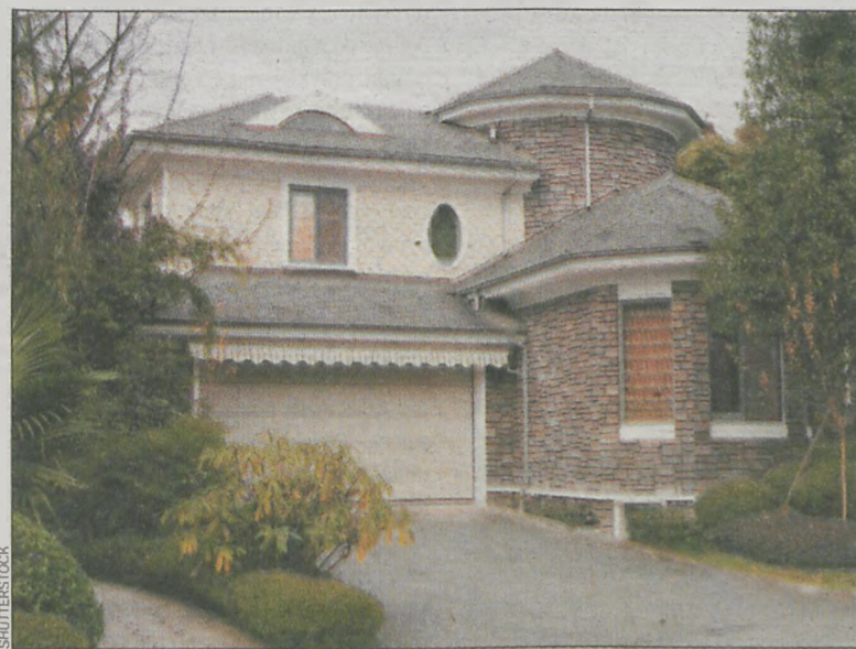
Aby zaoszczędzić na pokryciu elewacji, można okleić tylko część ścian
