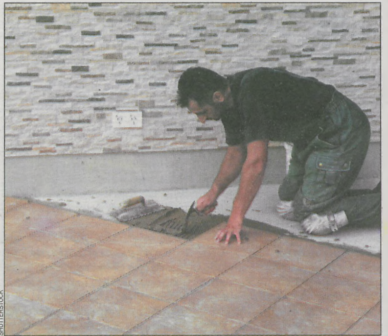
Układanie płytek w karo
