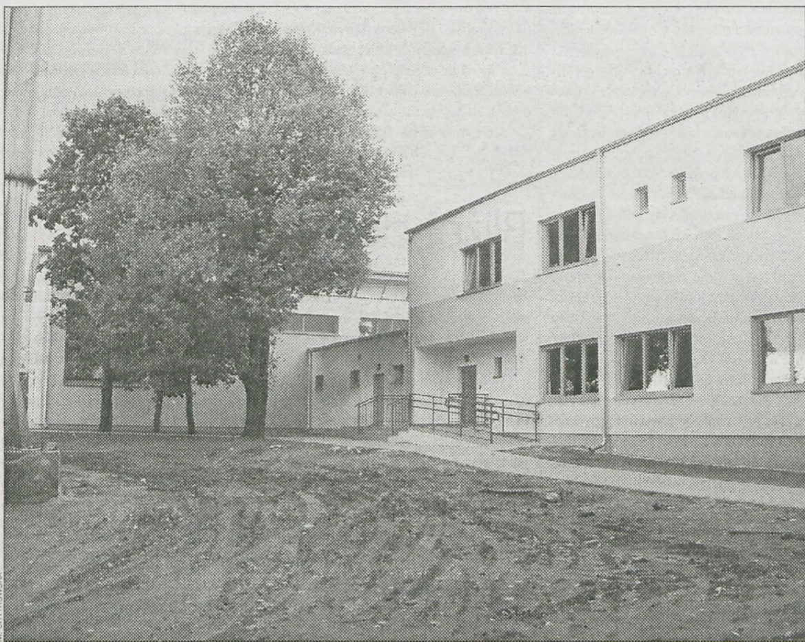
To w tym budynku spadł tynk z sufitu
