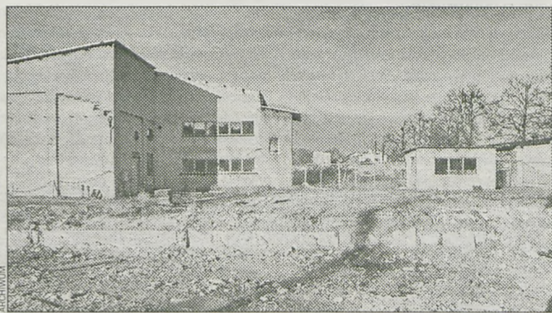
To w tym miejscu powstanie inwestycja
