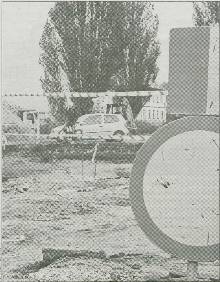
Budowa ronda ma potrwać do początku grudnia
