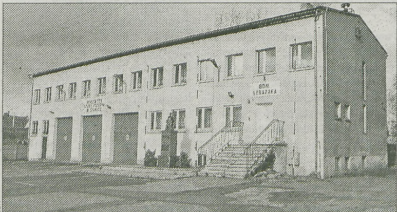
Ten budynek wymaga gruntownego remontu
