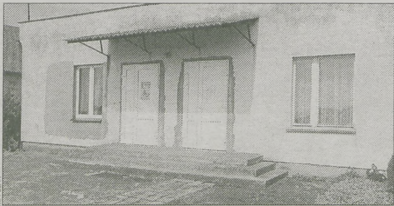
W świetlicy w Nepomucenowie zostanie naprawiony dach
