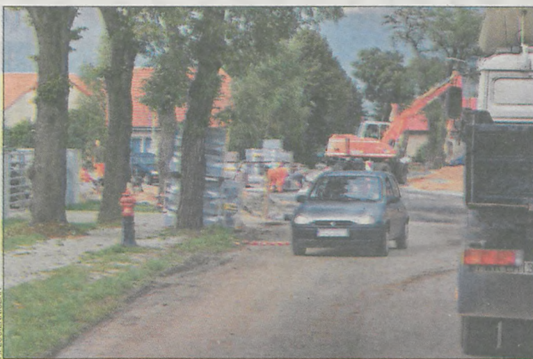
Droga – według zapewnień wykonawcy – jest już przejezdna
