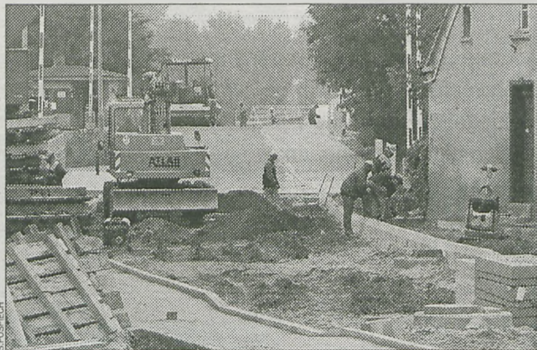
Trwają prace przy kanalizowaniu odcinka Rawickiej
