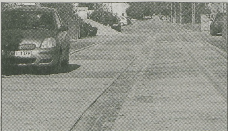
Na ul. Piaskowej zakończono już prace budowlane
