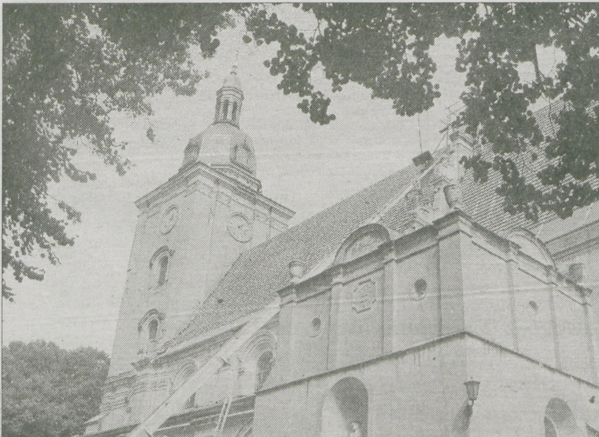
Prace dotyczą remontu konstrukcji i wymiany pokrycia dachu
