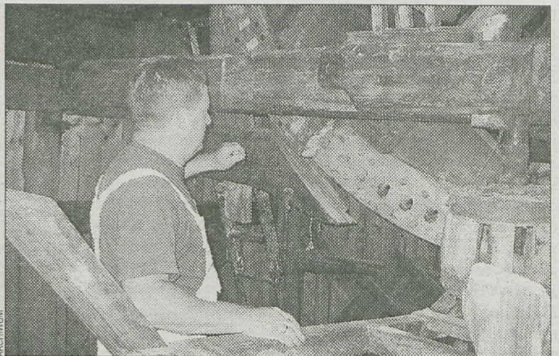
W ramach modernizacji wymieniono zęby wału
