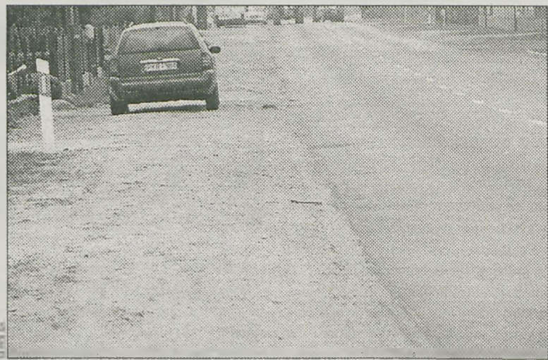
W mieście mają być wyremontowane nawierzchnie jezdni
