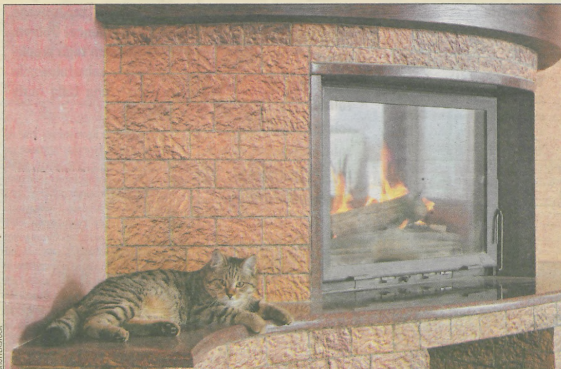
Dzięki zastosowaniu wkładu kominkowego około 80% energii cieplnej można wykorzystać do ogrzania domu
