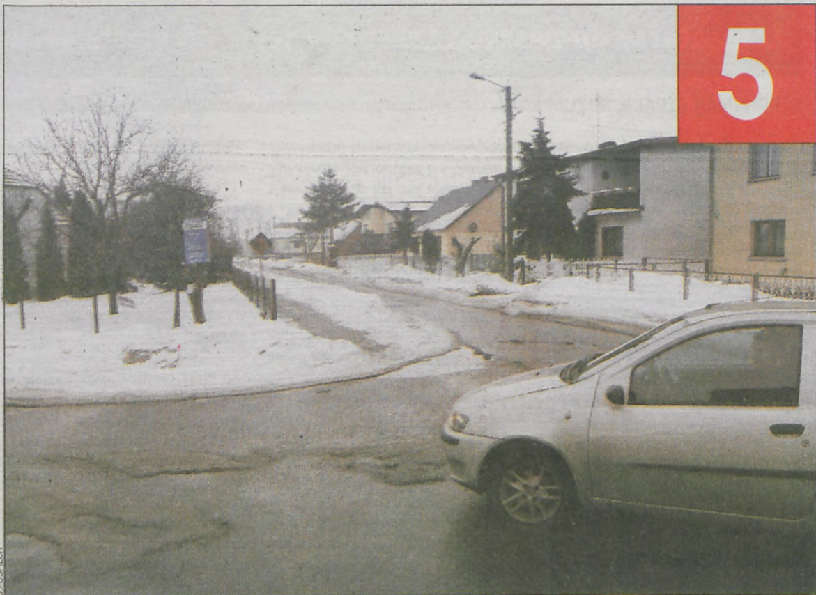
Przebudowa ma dotyczyć m.in. skrzyżowania ul. Osadniczej z Szosą Benicką
