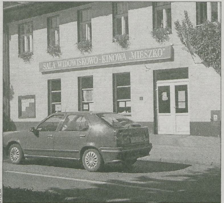
Do czerwca remont powinien zostać zakończony
