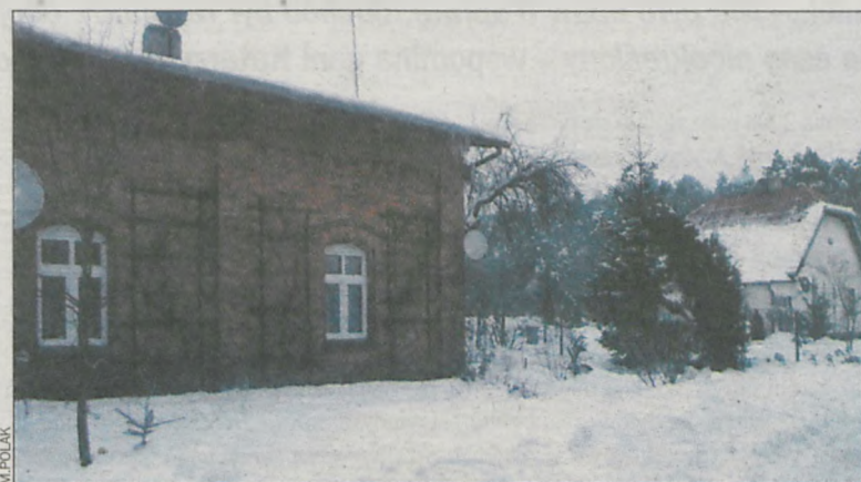
Mieszkańcy tych dwóch budynków będą płacić dwukrotnie wyższy czynsz
