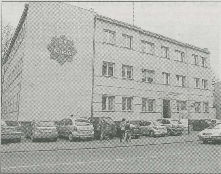
Już niedługo nowa elewacja budynku będzie ukończona
