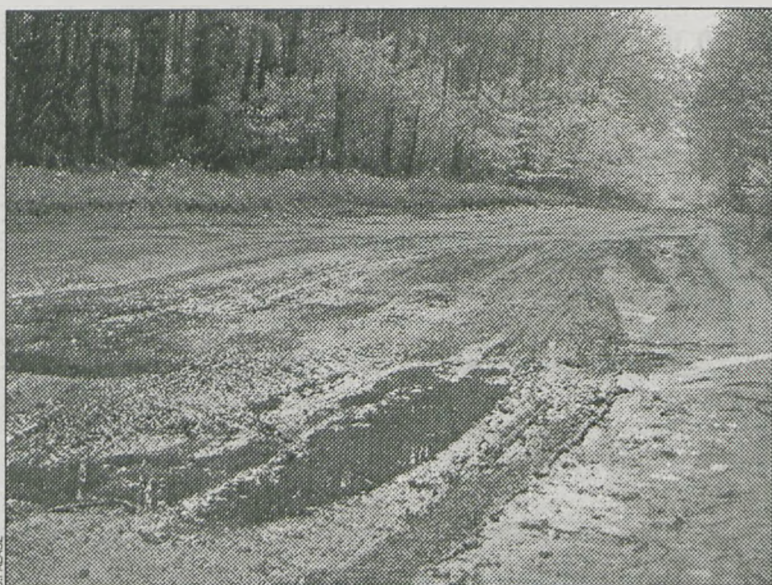
Z Nowego Folwarku do Jutrosina nadal będzie prowadzić droga gruntowa
