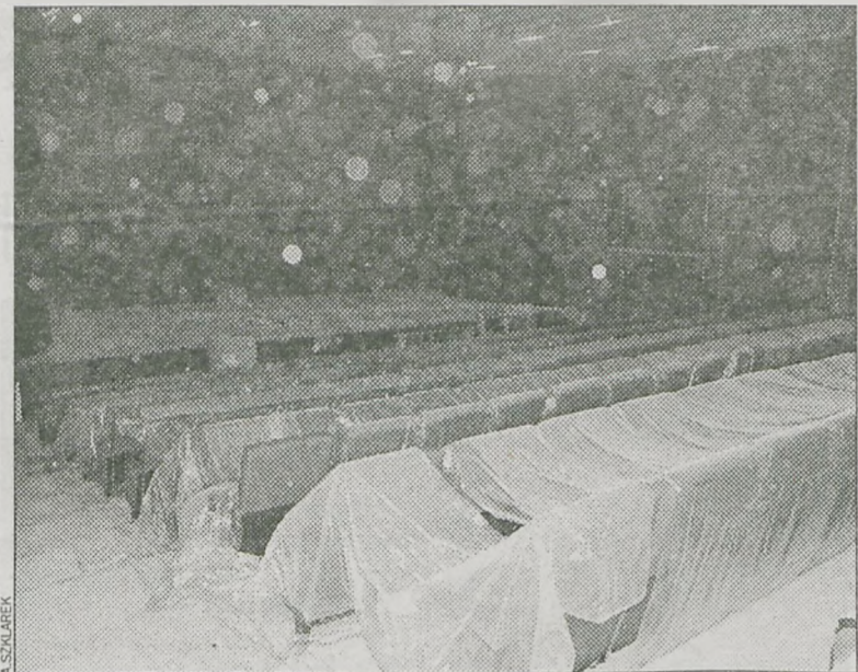
W obecnej chwili kino jest w trakcie remontu
