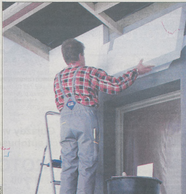
Styropian jest najczęściej stosowanym materiałem izolacyjnym w systemach ociepleń
