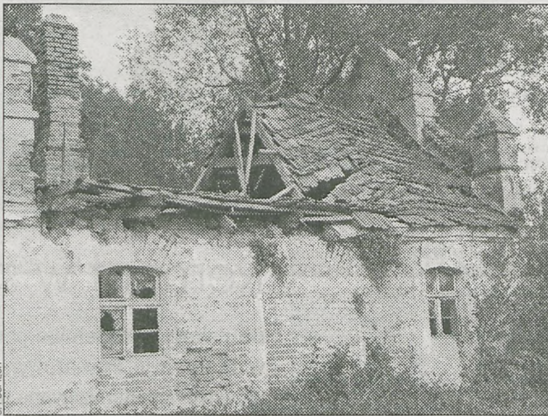
Dawna kuźnia w Starkówcu to dziś niestety ruina
