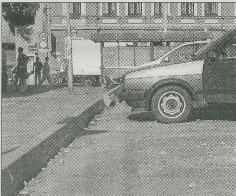
Na tym krawężniku doszło do uszkodzenia podwozia niejednego auta
