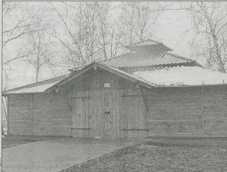
Drzwi wejściowe zostaną wymienione
