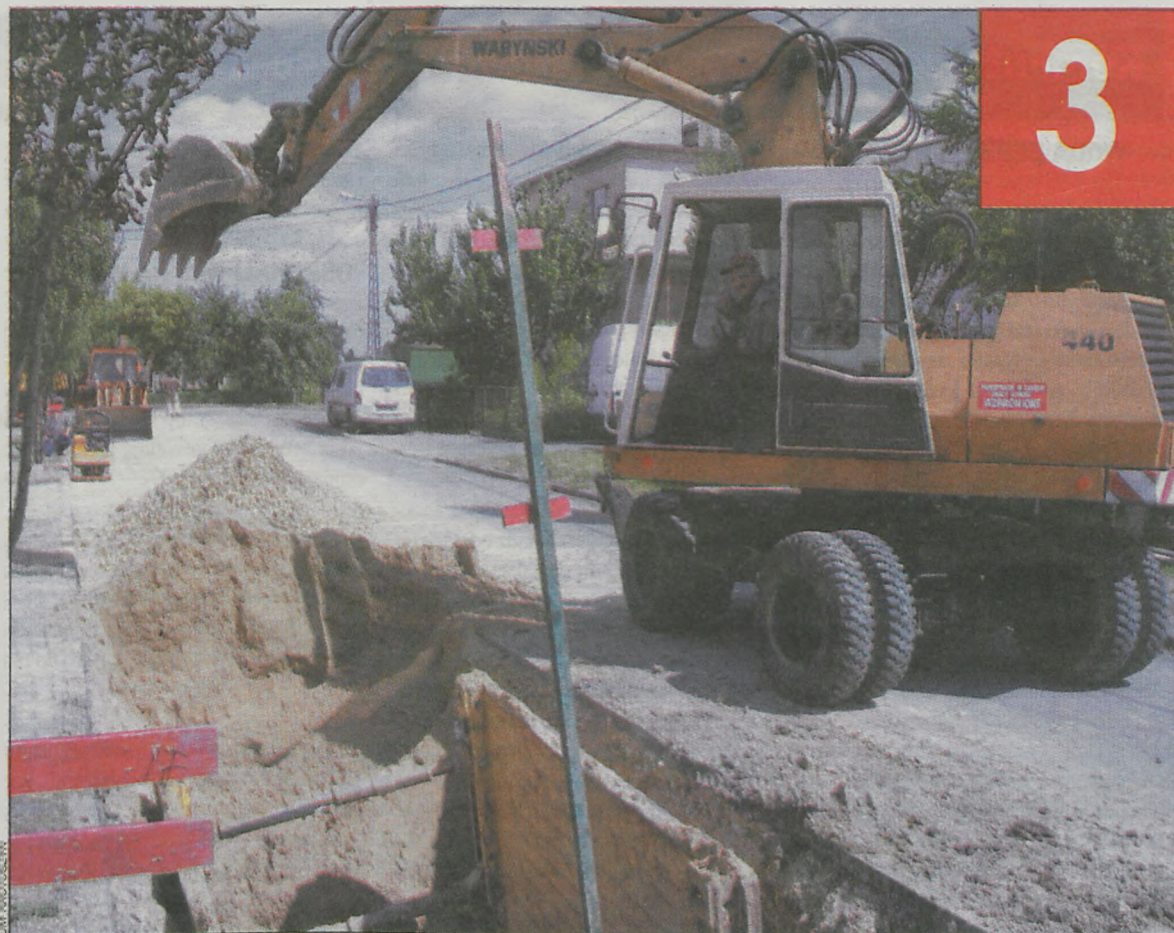
Kilka lat temu gmina skanalizowała osiedle Parcelki dzięki wsparciu pieniędzy unijnych
