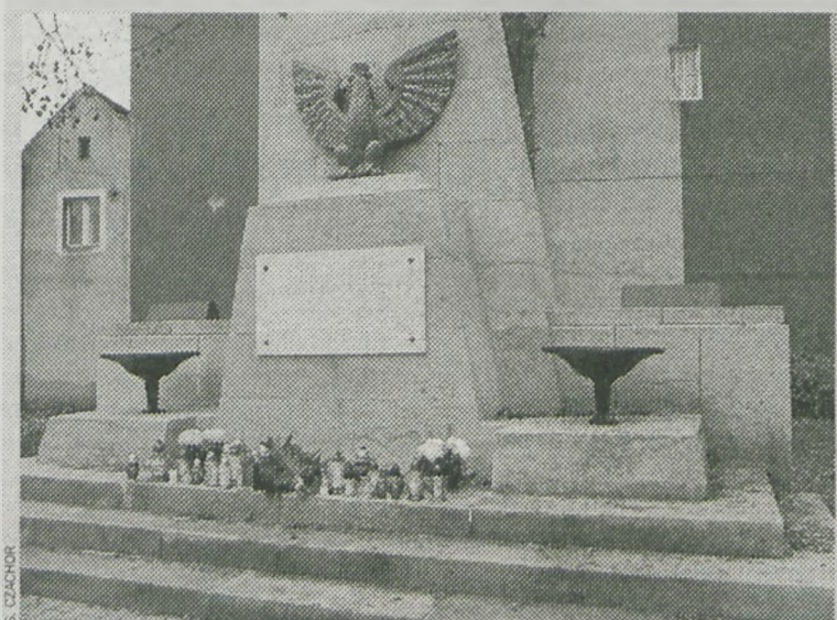
Pomnik jak nowy. Pomnik Powstańców Wielkopolskich stojący u zbiegu ulic Zduńowskiej i Klonowicza po wielu latach doczekał się remontu. Oczyszczono piaskowiec i odnowiono odlew orła. Prace zakończono przed Świętem Niepodległości 11 listopada i monument można oglądać w pełnej krasie. (mik)
