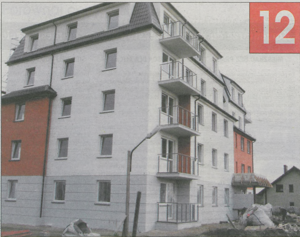
Niestety tylko jeden developer rozpoczął budowę bloków w Krotoszynie
