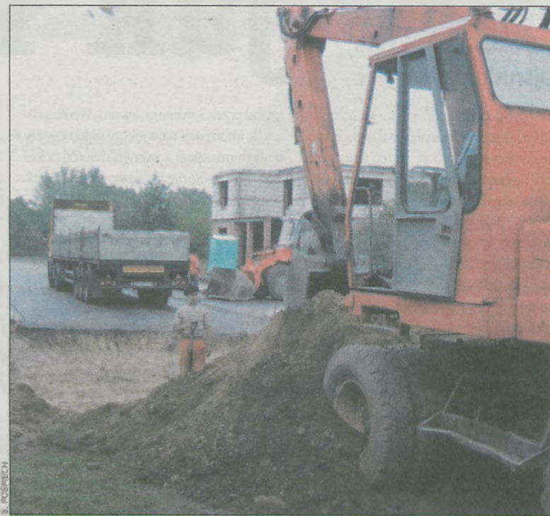
Roboty budowlane w ramach inwestycji urzędu miejskiego
