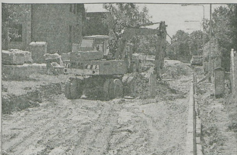
Prace na rozpoczętym odcinku są już bardzo zaawansowane
