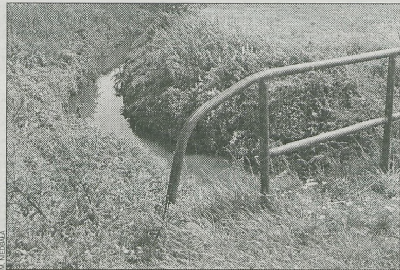
W tym rejonie Jawnik wpływa do oczyszczalni ścieków
