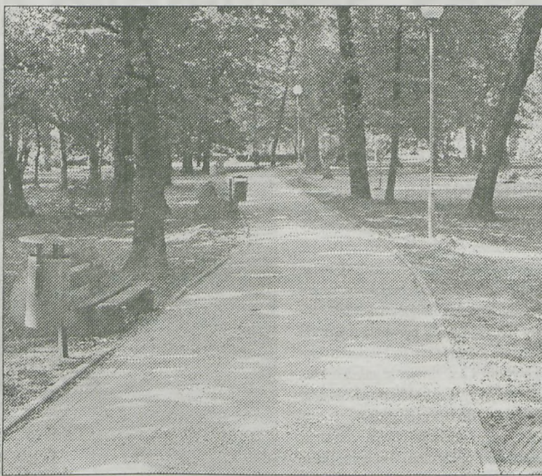
Aleja w trakcie remontu
