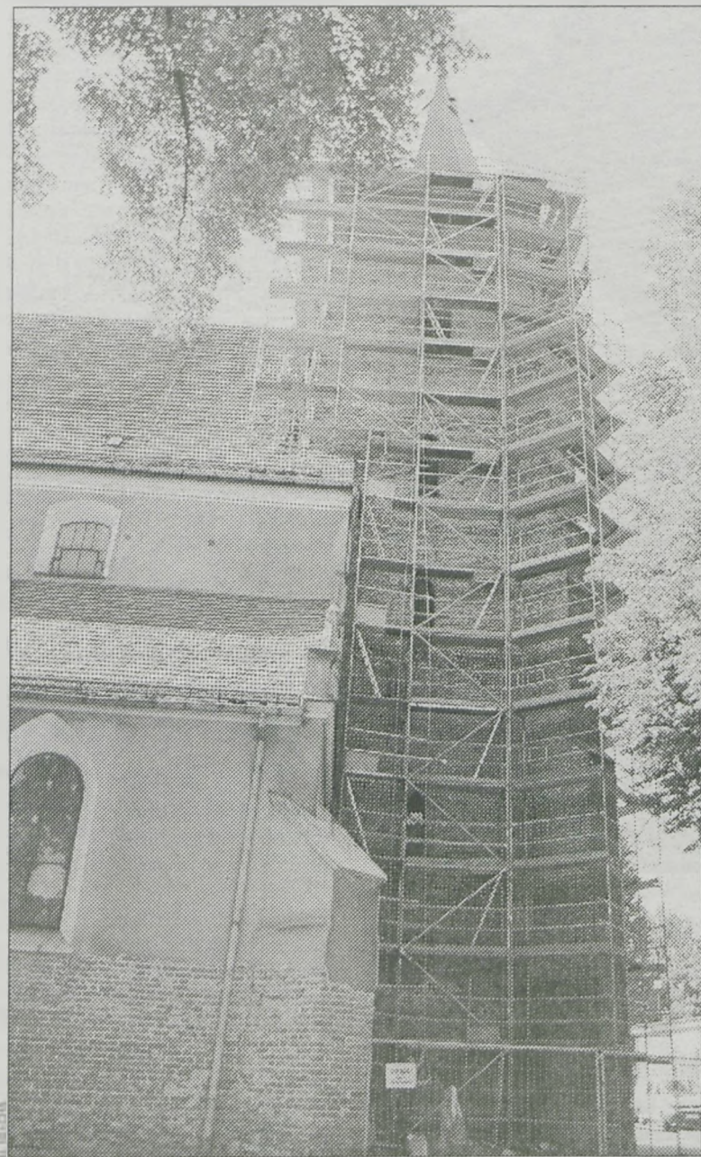
Remontowana wieża w całej okazałości
