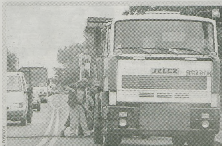
Łatanie dziur. W piątkowe przedpołudnie na drodze krajowej nr 15 w Krotoszynie tworzyły się korki. Przyczyną tego stanu rzeczy było łatanie dziur wykonywane przez pracowników Generalnej Dyrekcji Dróg Krajowych.
