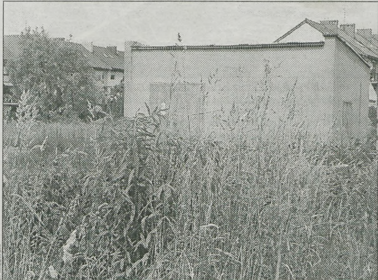
Stację transformatorową otacza wysoka trawa
