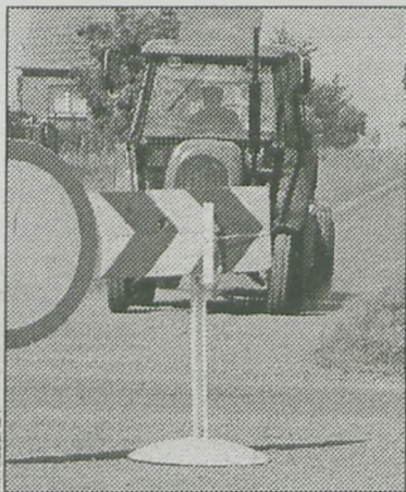
Wkrótce będzie tu asfalt
