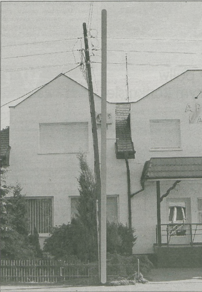
Słup na ul. Staszica jest znacznie odchylony od pionu
