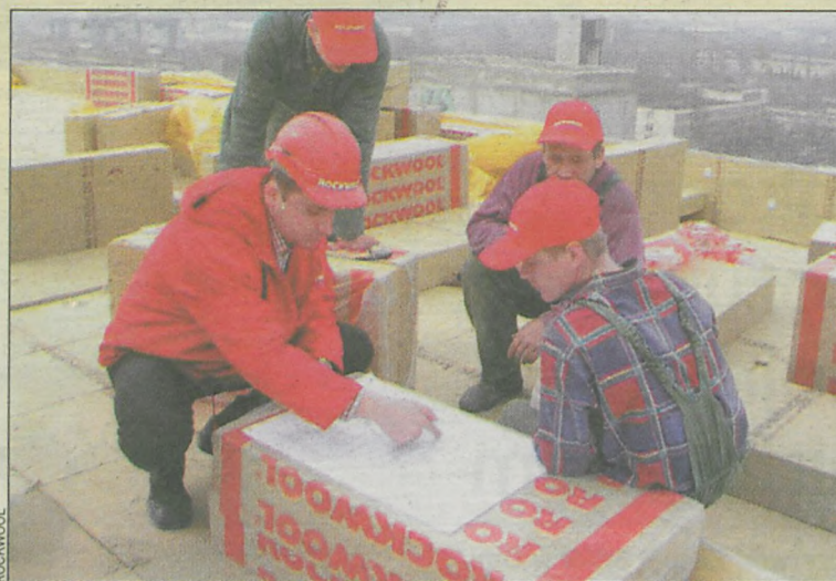
Zaizolowany dach chroni przed utratą ciepła
