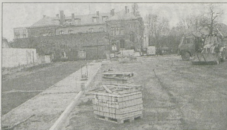
W miejscu wyburzonych trybun (po lewej) powstanie bieżnia
