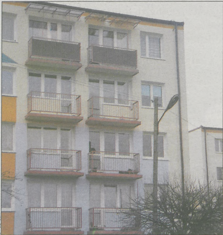
Krotoszyńska spółdzielnia posiada 66 budynków, większość to bloki mieszkalne
