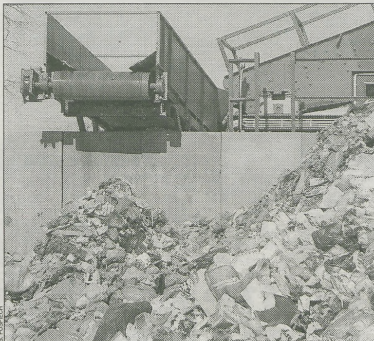
Krotoszyńskie wysypisko jest punktem przeładunkowym odpadów komunalnych
