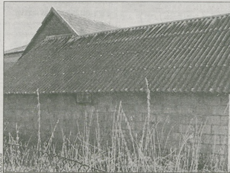
Wiele dachów w naszym kraju pokrywają płyty eternitowe
