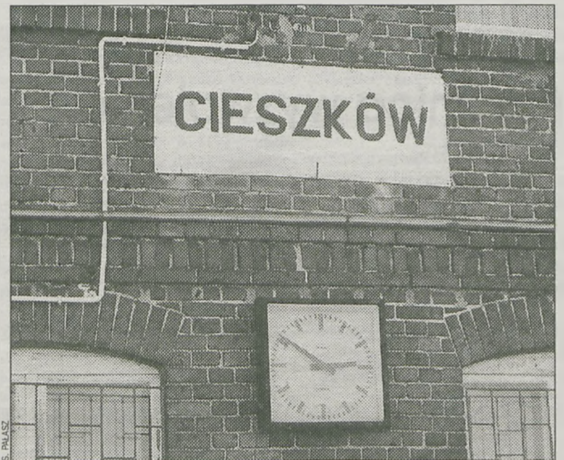
Przed rokiem gmina wyremontowała poczekalnię
