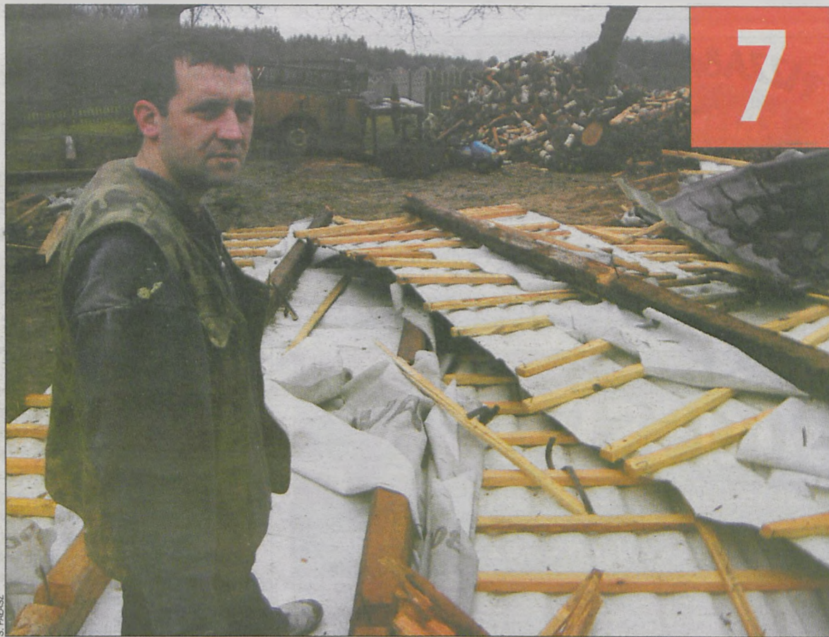
Całe szczęście, że gdy dach runął na ziemię, nikogo nie było na podwórku – mówi Leszek Baszczak
